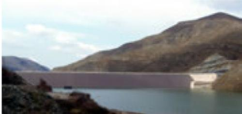
Presa de materiales sueltos sin núcleo impermeable y con pantalla de impermeabilización externa del embalse de Terroba en el río Leza.
