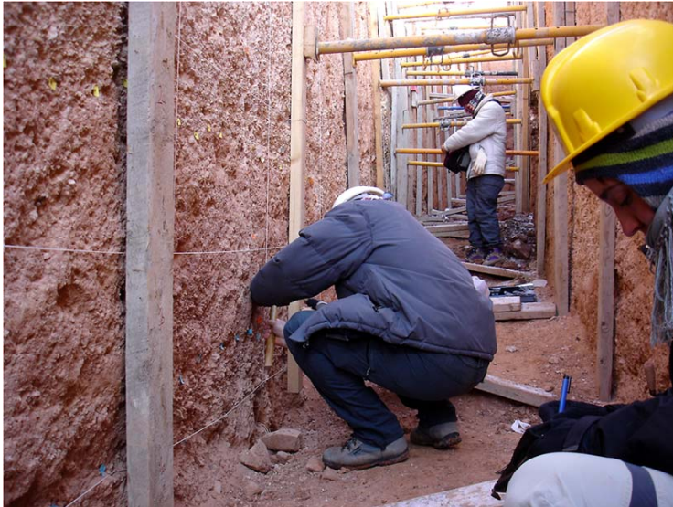
Foto: Trincheras en la Falla de Concud: limpieza de paredes, trazado de cuadrícula de referencia, marcado de contactos y fallas.
