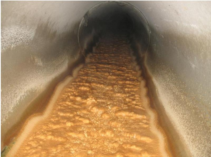
*Depósitos carbonatados en una tubería de desagüe del balneario de Fitero (Navarra).*
