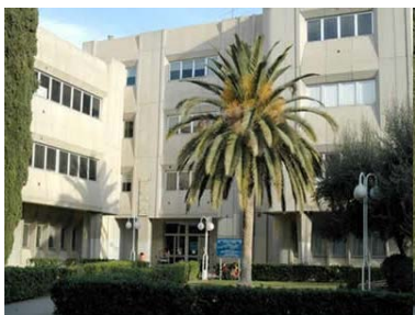
Edificio de Geológicas Campus San Francisco c/Pedro Cerbuna, nº12 (borde N del campus, frente calle Menéndez Pelayo) https://cienciatierra.unizar.es/
